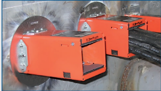
Metalen schotten van de testmuur van het WFRC.
